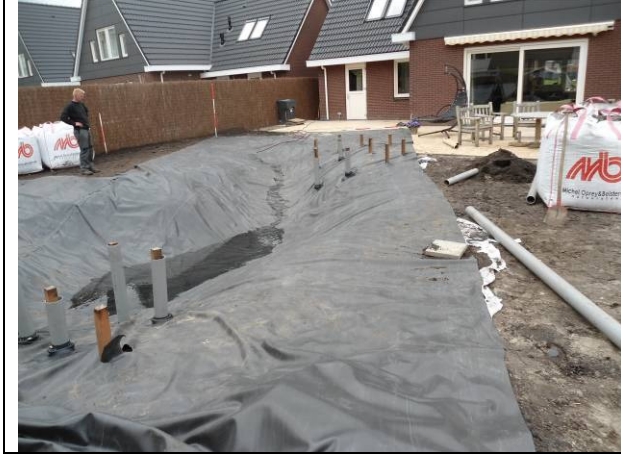
EPDM vijver te Grou
