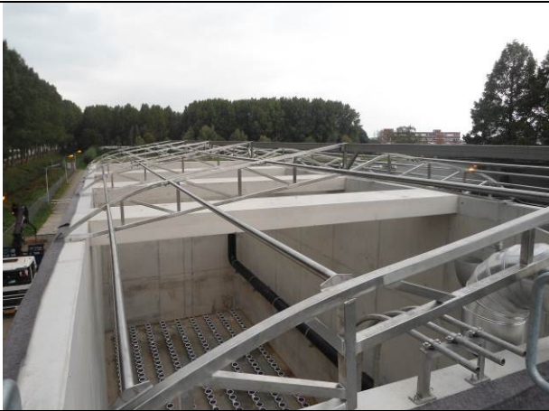
RVS spanten gereed
