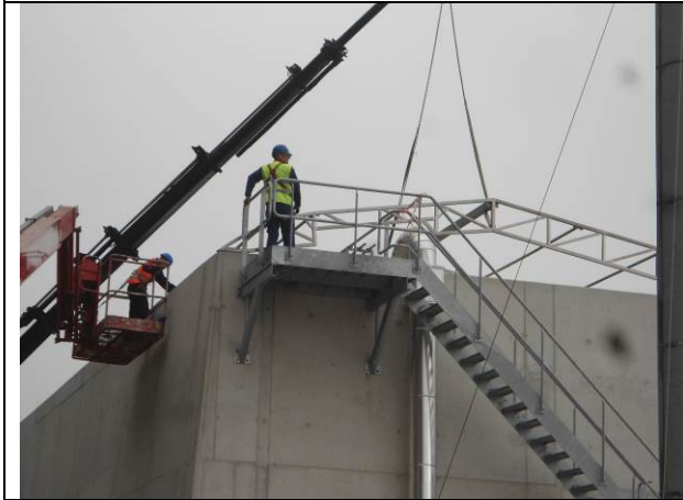
Plaatsing RVS spanten
