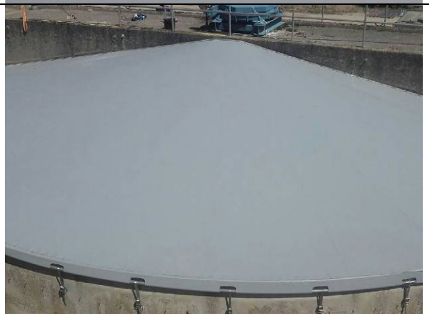
Halve maan kap gereed. Aftgespannen met randbuis en RVS ratels.
