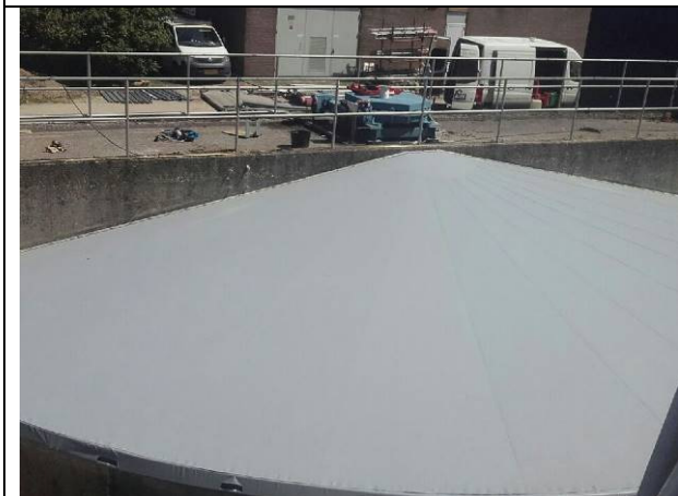
RVS daklijn strip op betonnen loop brug.
