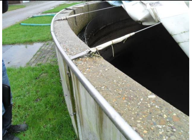
Behoud van RVS staaldraad spanten.
